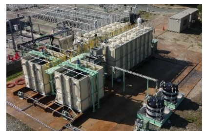
写真：実証施設の外観
